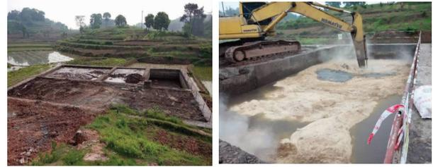
图 1 某钻井队完井固废生物处理资源化土壤利用
